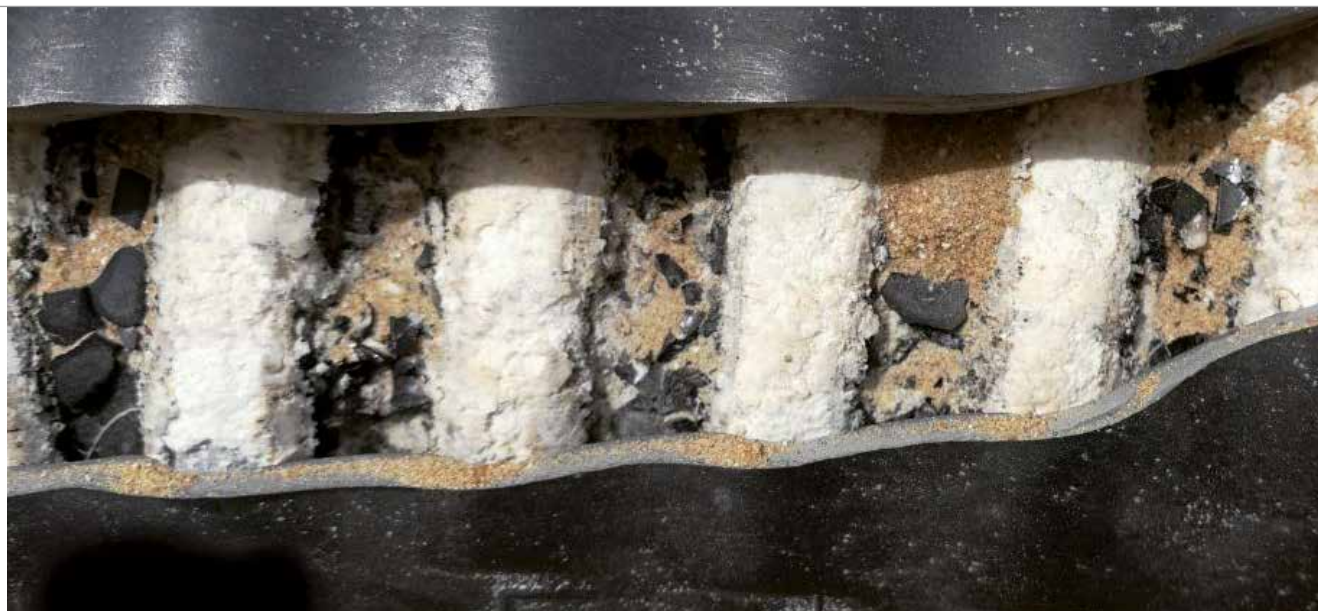
Korrodiertes Kabel mit Aluminium-Ummantelung aus dem Mittleren Osten
