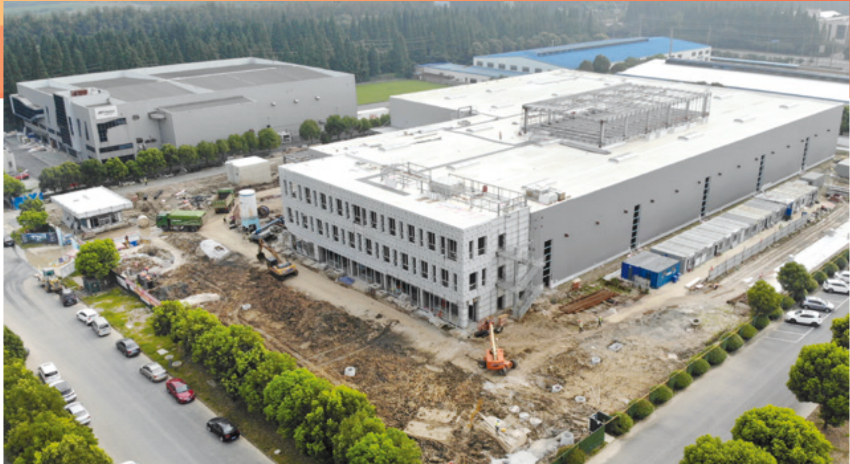
Bild 1. Die Bauarbeiten an der neuen NMC-Fabrik gehen zügig voran.
