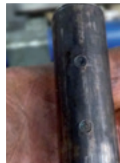
Bild 5. Besprührrohr bei Demontage der Rohrleitung.
