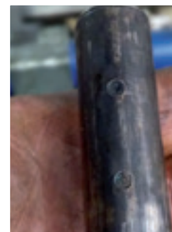
图5 拆卸时的喷淋管路
