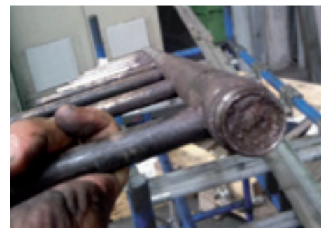
图4 拉丝模喷淋管路被铜泥堵塞
